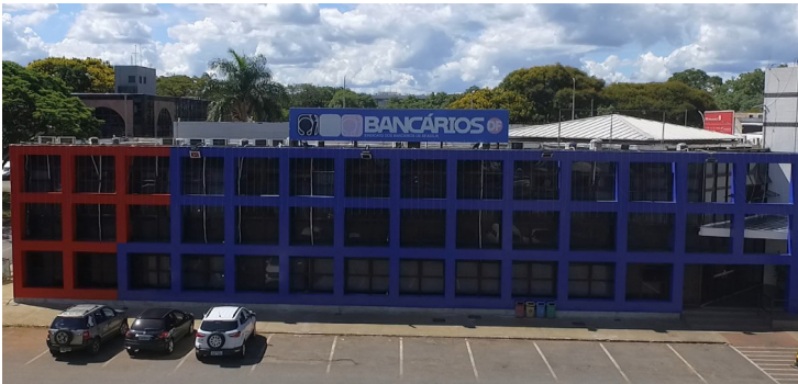
Sede do Sindicato EQS 314/315, Bloco A – Asa Sul
