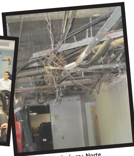
Vistoria na agência da 504 Norte
